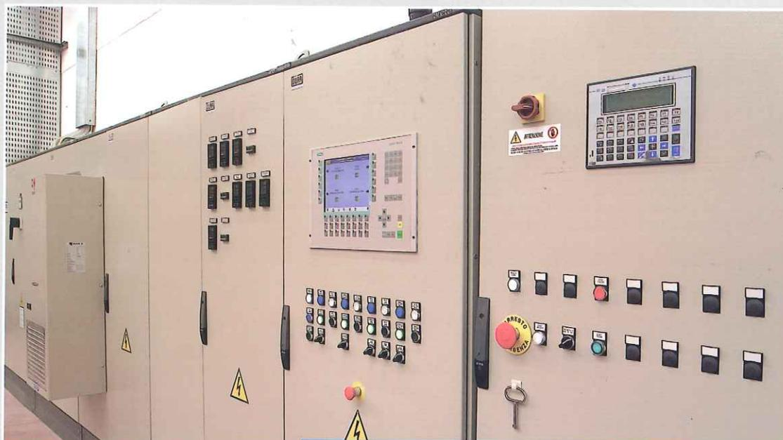
Il processo di verniciatura è controllato in ogni suo ciclo, (temperatura, umidità, avanzamento prod.) da PLC, che garantisce la qualità del prodotto.
